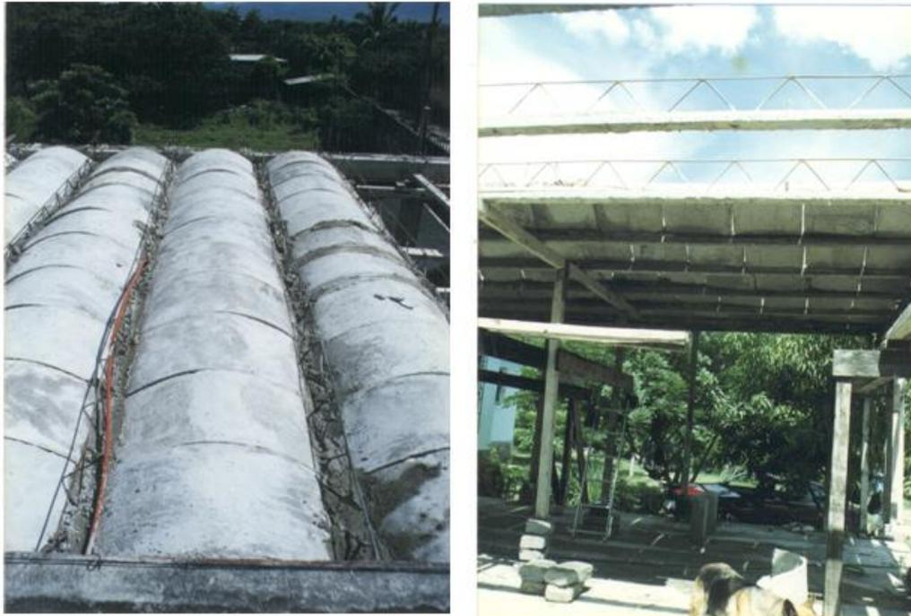
Figura 18.- Colocación de Instalación Eléctrica y ausencia de cimbras(solo apoyos mediante vigas)
