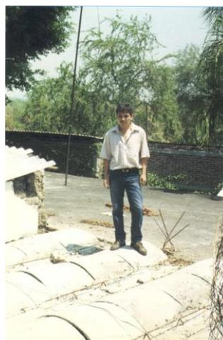
Y en la fotografía de la derecha que corresponde a la misma obra, se aprecian las bóvedas ya amacizadas a las viguetas, permitiendo el tránsito sobre ellas para realizar la fase final que será el relleno de los huecos entre bóvedas aplicando un concreto de  $f'c = 80$  a  $100 \text{ kg / cm}^2$ , de preferencia con
