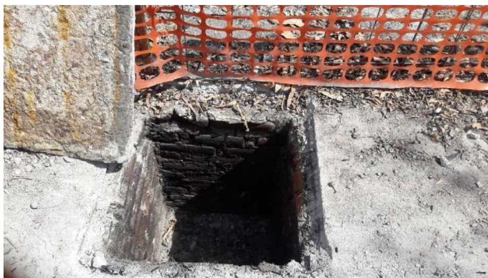
Reparación de registro y desazolve.
