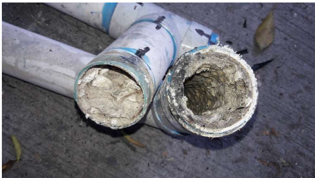
Cambio de tubería de instalaciones sanitarias
