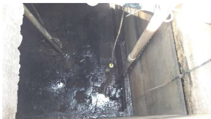
Segunda cámara del sistema con desazolve realizado
