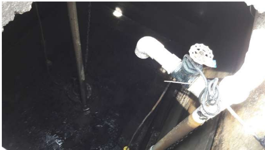
Cámara de aireación después del desazolve.
