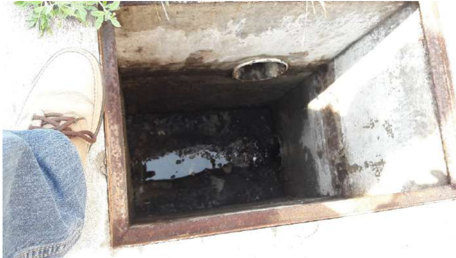
Registro después del desazolve.
