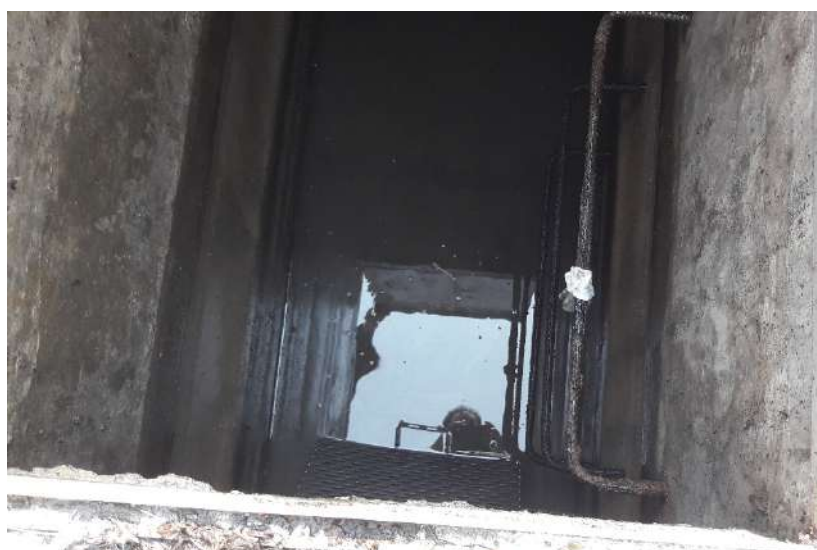
Primer cámara del sistema con desazolve realizado.
