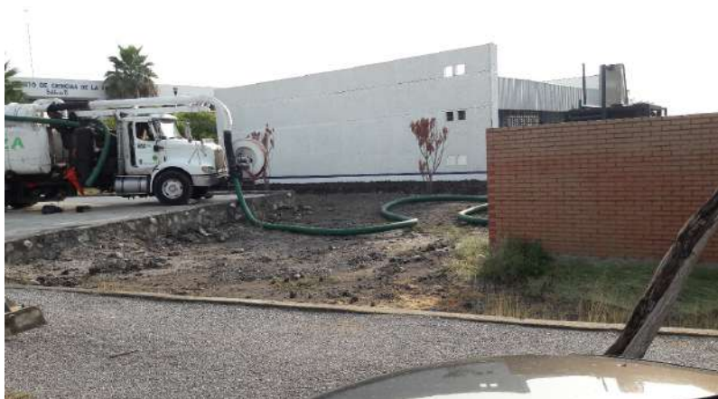
Vactor del proveedor para realizar el saneamiento del biorreactor y tubería de drenaje
