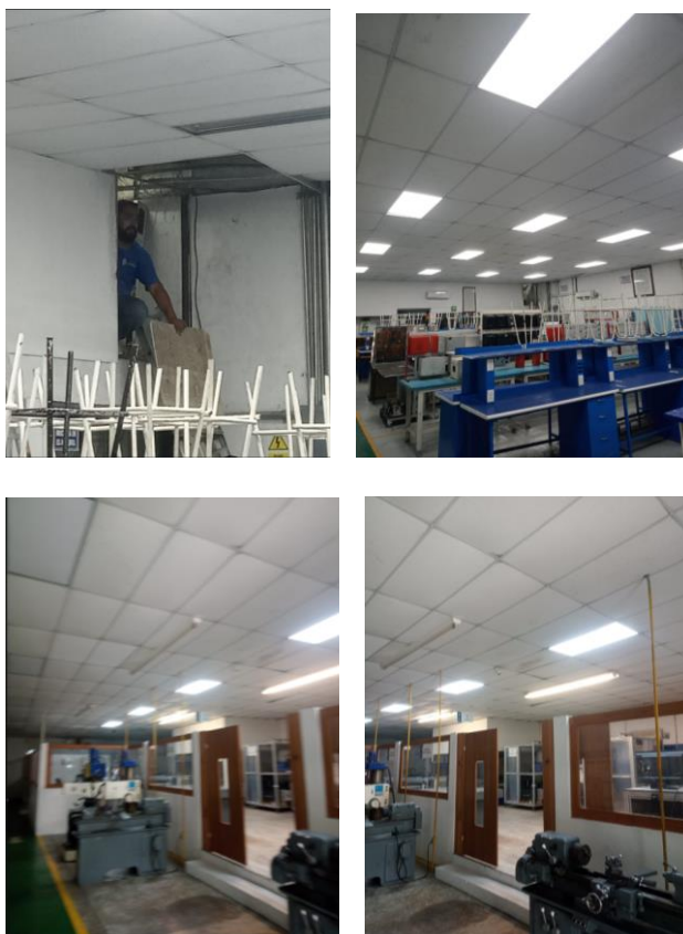
Reemplazo de plafones en laboratorios.
