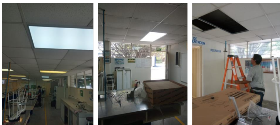
Reemplazo de luminarias en laboratorio de análisis ligeros.
