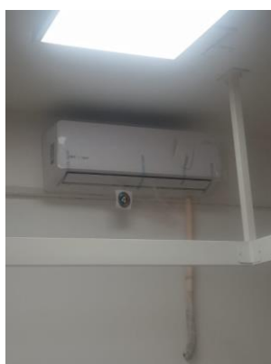
Instalación de equipo de aire acondicionado en laboratorio de logística.
