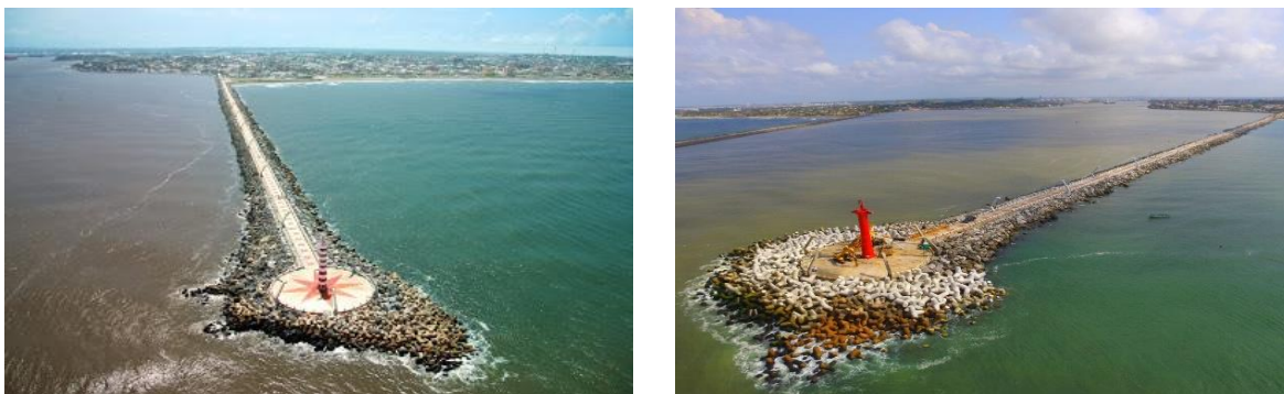
Figura 25 y 26. Escollera de Coatzacoalcos antes de su rehabilitación con severos daños y después de la reparación de la misma.
