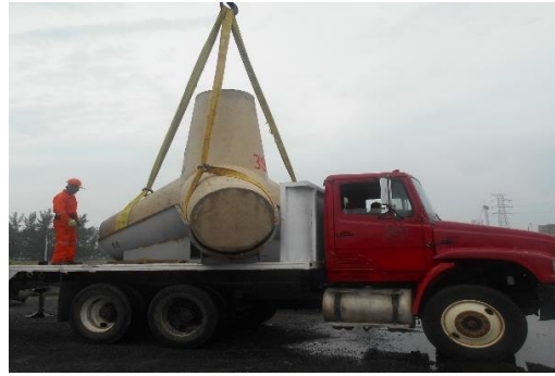
Figura 17 y 18. Aplicación de curacreto y traslado de los tetrapodos del patio de colados al patio de almacenamiento
