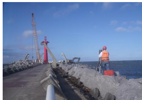
Figura 3 y 4. Trabajos relacionados con el trazo y nivelación con equipo topográfico.
