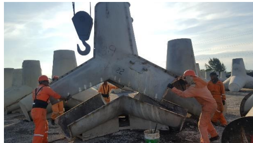
Figura 11 y 12. Limpieza de los moldes y armado de los mismos.
