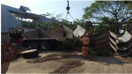
Figura 9 y 10. Transporte de los moldes al lugar del patio de colados para su fabricación
