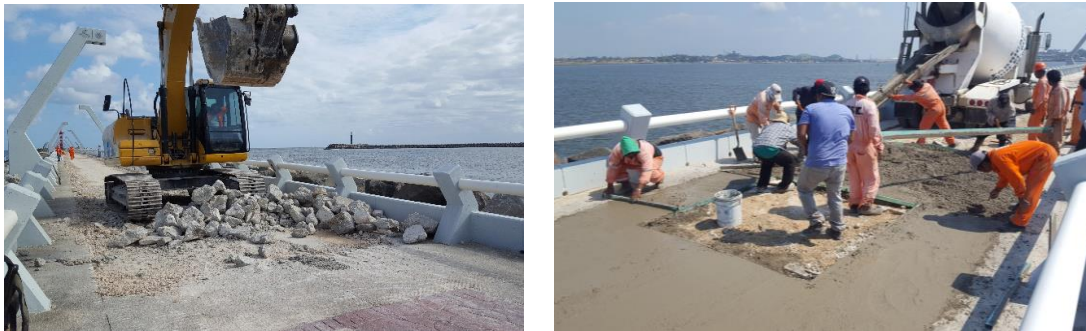
Figura 23 y 24. Remoción del material de demolición de la calzada de la escollera y suministro de concreto en la misma.
