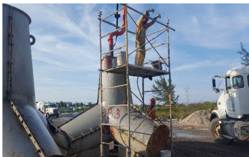
Figura 15 y 16. Colado y descimbrado de los moldes de los elementos prefabricados (tetrápodos)
