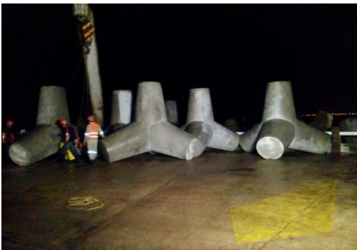
Figura 19 y 20. Traslado de los tetrapodos del patio de almacenamiento al lugar de la obra y colocación de los tetrapodos en el cuerpo de la escollera
