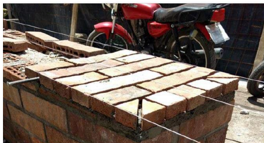
Figura 8. Muro exterior de Tabique
