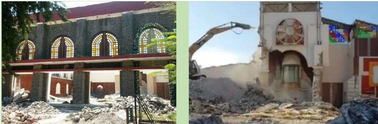
Figura 4. Demolición y remoción de escombros
