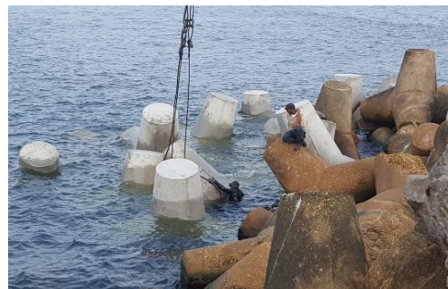
Figura 21 y 22. Colocación de los tetrapodos en el cuerpo de la escollera con apoyo de personal de buzo para la orientación de las piezas.
