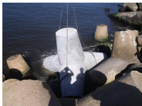
Figura 19 y 20. Traslado de los tetrapodos del patio de almacenamiento al lugar de la obra y colocación de los tetrapodos en el cuerpo de la escollera
