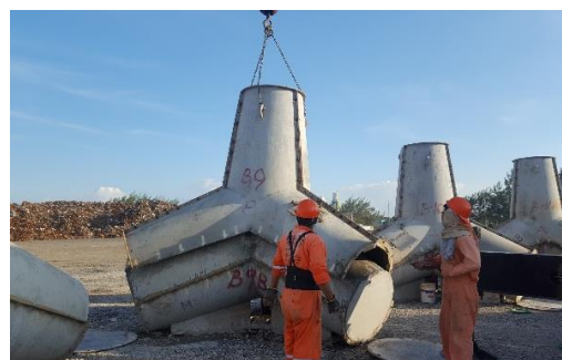
Figura 15 y 16. Colado y descimbrado de los moldes de los elementos prefabricados (tetrápodos)
