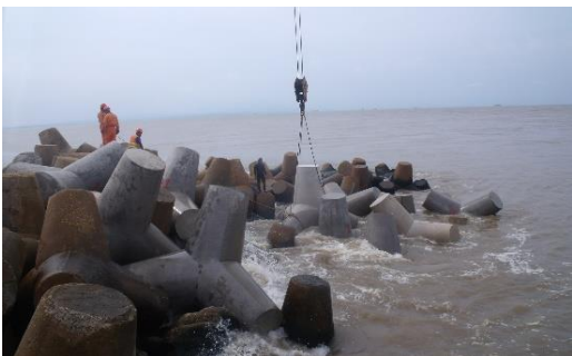
Figura 21 y 22. Colocación de los tetrapodos en el cuerpo de la escollera con apoyo de personal de buzo para la orientación de las piezas.
