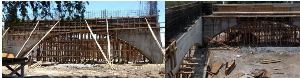
Figura 7. Muros de concreto
