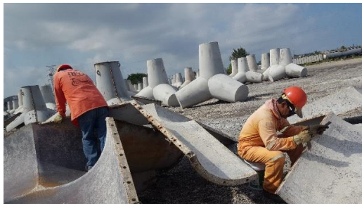
Figura 11 y 12. Limpieza de los moldes y armado de los mismos.
