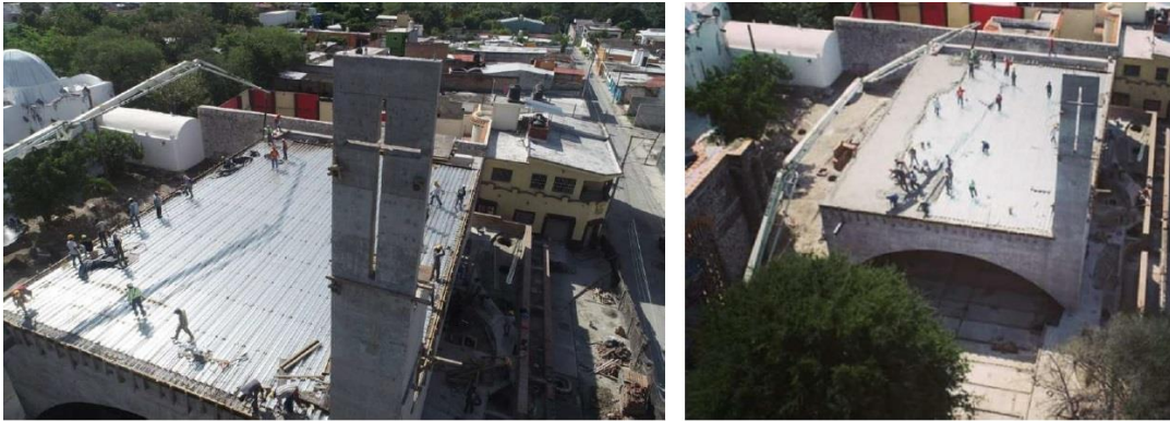
Figura 13. Losa acero
