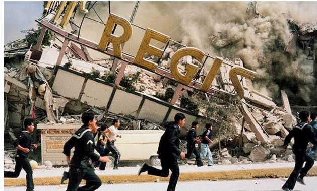
Figura 1.- Figura donde se aprecia el colapso del Hotel Regis en la Ciudad de México. Sismo del 19 de septiembre de 1985.
