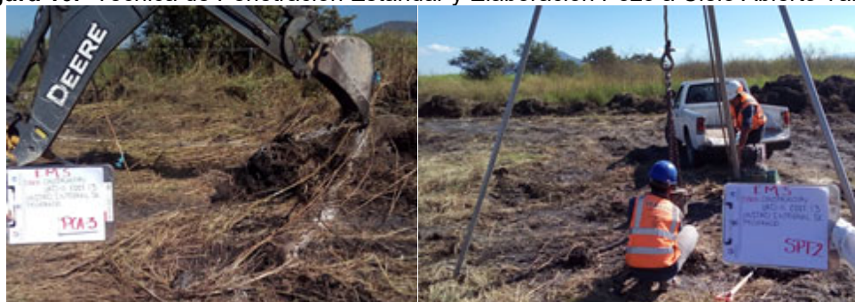
Figura 11.- Técnica de Penetración Estándar y Elaboración Pozo a Cielo Abierto para UAD-II No.13
