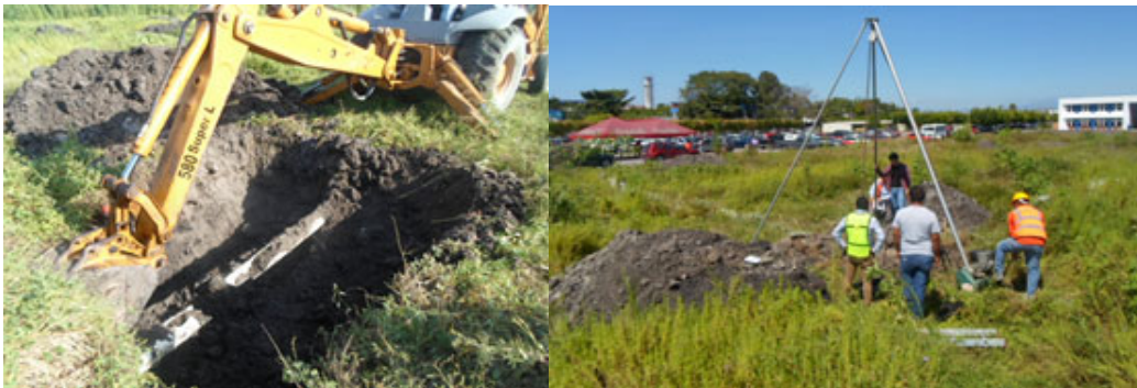
Figura 5.- Técnica de Penetración Estándar y Elaboración Pozo a Cielo Abierto para UAD-II No. 10
