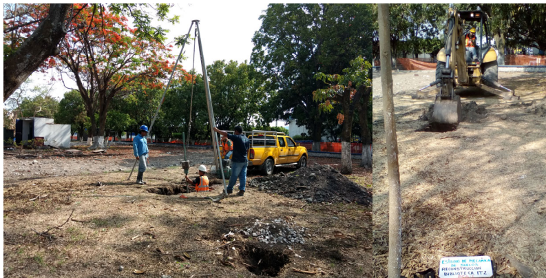
Figura 2.- Técnica de Penetración Estándar y Elaboración Pozo a Cielo Abierto
