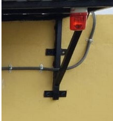
Figura 11.- Torreta que indica alguna falla en el gabinete
