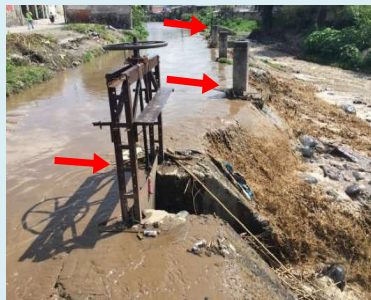
Figura 7.- Compuertas de la presa derivadora.
