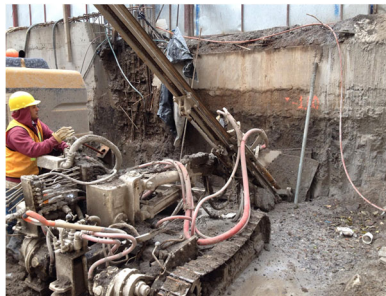
Figura 1. Máquina de perforación Trackdill de mediana capacidad
