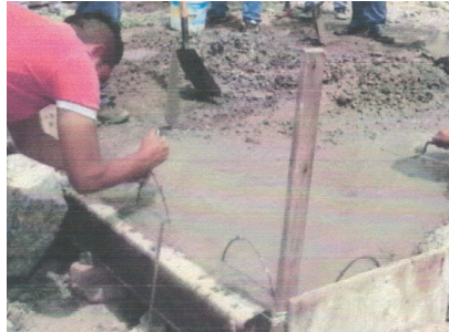
Figura 2. Colocación de anclajes sobre el firme
