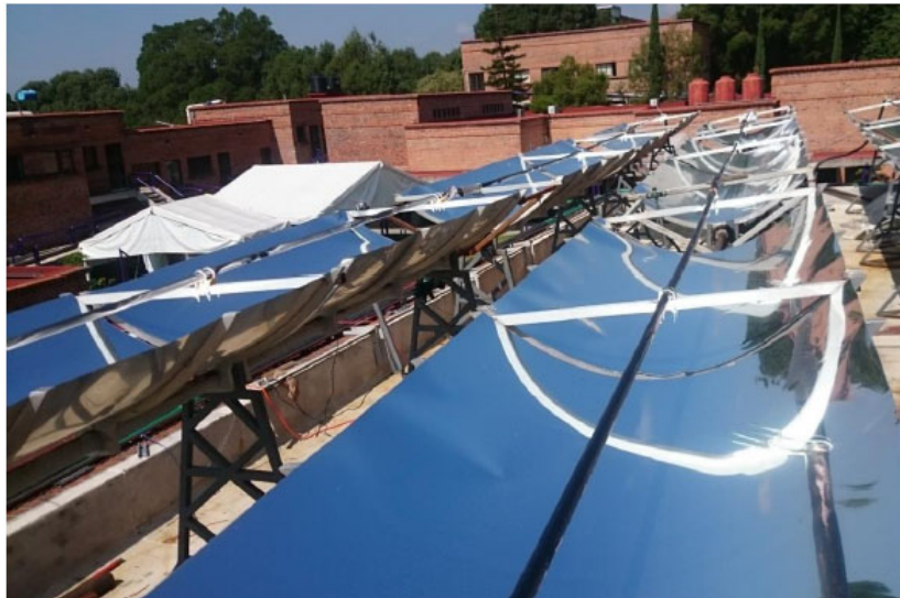
Figura 1. Planta de Concentradores Cilindro Parabólico
