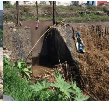
Figura 9.- Las compuertas presentan azolvamiento tanto como de vegetación como de basura.
