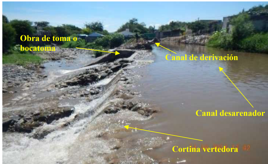
Figura 3.- Principales partes o componentes de la Presa en estudio
