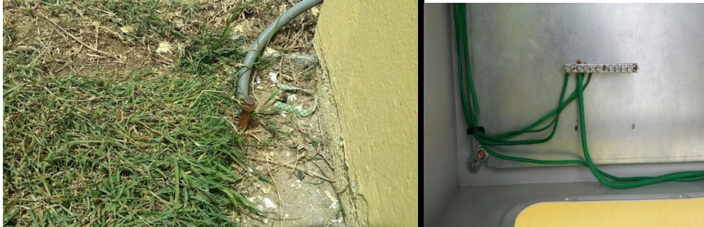
Figura 9.- Electrodo proveniente del gabinete colocado en la esquina de la planta
