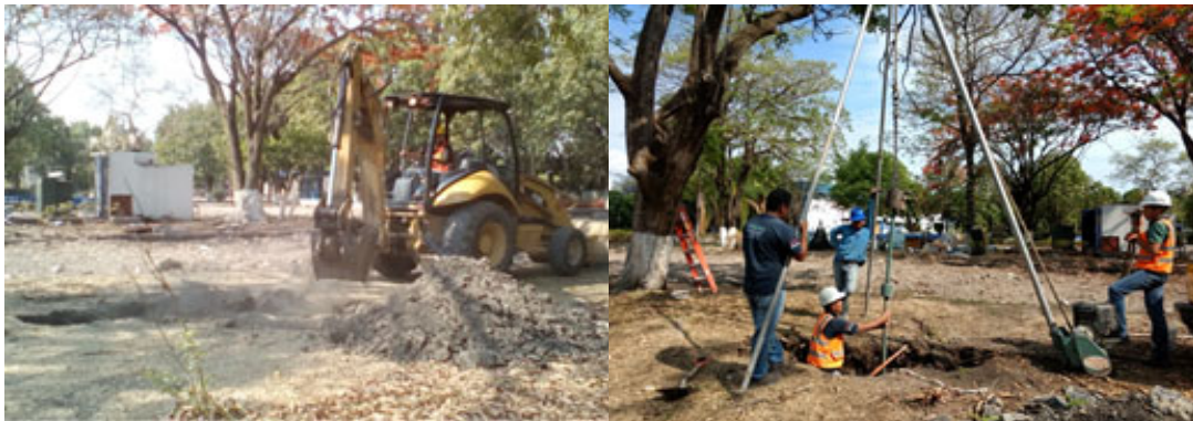
Figura 9.- Técnica de Penetración Estándar y Elaboración Pozo a Cielo Abierto Biblioteca
