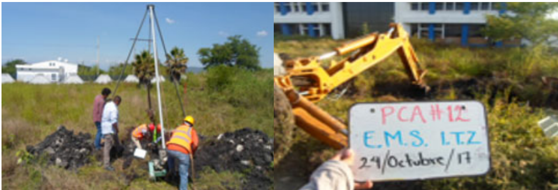
Figura 6.- Técnica de Penetración Estándar y Elaboración Pozo a Cielo Abierto Lab. Química
