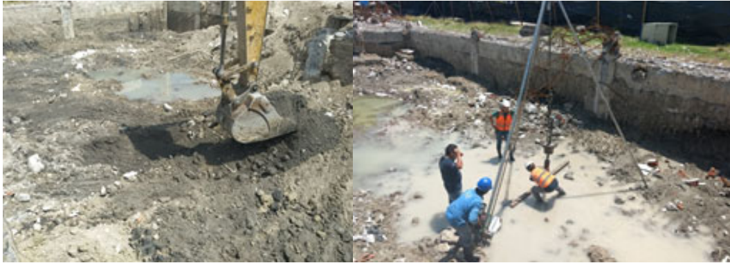
Figura 8.- Técnica de Penetración Estándar y Elaboración Pozo a Cielo Abierto Centro de Cómputo.
