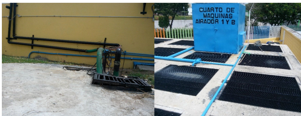
Figura 2.- Cárcamo de la PTAR del hospital y el cuarto de máquinas, aireadores y tren de filtraje.
