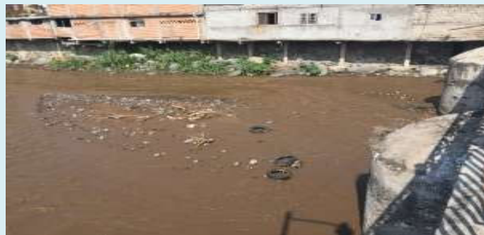
Figura 3.- Azolvamiento en el embalse de la presa derivadora.
