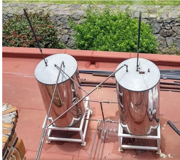
Figura 3. Termo tanques con 300 L de capacidad cada uno.
