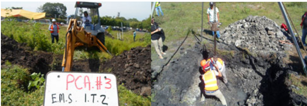
Figura 3.- Técnica de Penetración Estándar y Elaboración Pozo a Cielo Abierto para UAD-II No. 8
