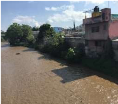
Figura 10.- Asentamientos urbanos a las orillas de la presa derivadora.
