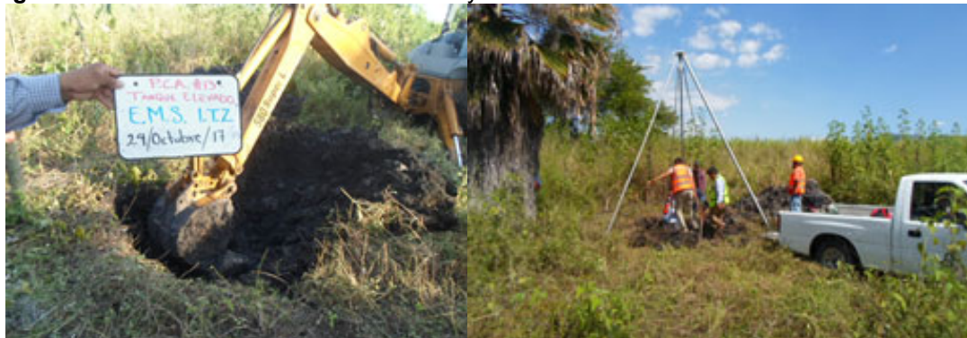
Figura 7.- Técnica de Penetración Estándar y Elaboración Pozo a Cielo Abierto Tanque Elevado
