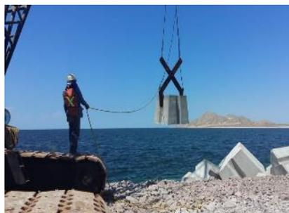
**Figura 20.-** Colocación de cubos ranurados en el rompeolas.
