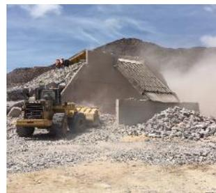
**Figura 12.-** Cribado del material.
