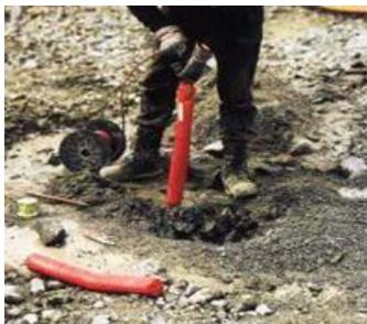
**Figura 6.-** Carga de los barrenos para su posterior detonación.
