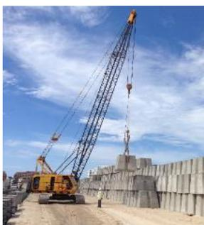
**Figura 18.-** Movimiento y almacenado de los cubos ranurados.
