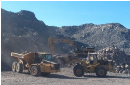
Figura 11.- Equipos utilizados para cribar el material.
