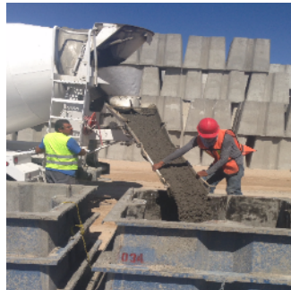
Figura 16.- Colado en los moldes para los cubos ranurados del rompeolas.
