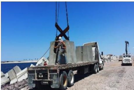
Figura 19.- Acarreo y transporte de los cubos ranurados al lugar de la obra.
