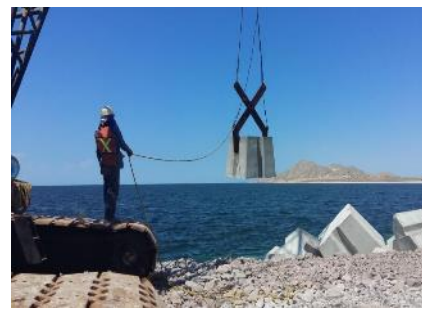
Figura 20.- Colocación de cubos ranurados en el rompeolas.
