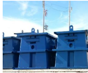
Figura 15.- Terminación de los moldes para los elementos pré-fabricados del rompeolas (cubos ranurados de concreto).
