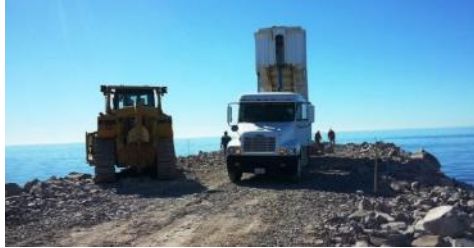
Figura 13.- Equipos y actividad de vertido de roca para el núcleo del rompeolas.
