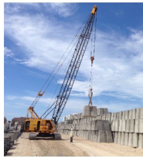
Figura 18.- Movimiento y almacenado de los cubos ranurados.
