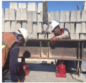
Figura 17.- Retiro de la cimbra con apoyo de estructura metálica y camión grúa.
