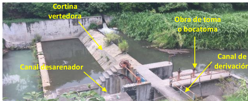
Figura 4.- Panorámica y principales estructuras de la presa derivadora Agua Hedionda.
