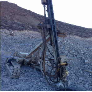
Figura 5.- Track Drill. Realiza la barrenación en el banco de materiales.
