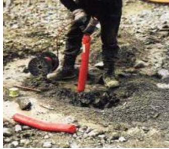
Figura 6.- Carga de los barrenos para su posterior detonación.
