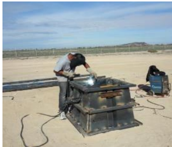
Figura 14.- Fabricación de los moldes para los elementos pré-fabricados del rompeolas (cubos ranurados de concreto).
